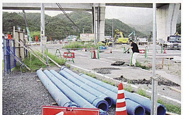
仮設管(PEPΦ200)の一部撤去
