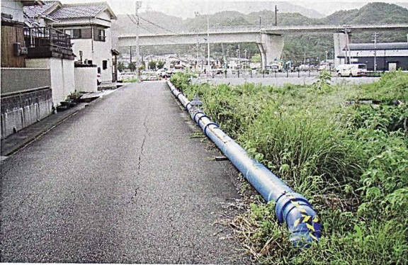
⑨5年以内をめざし復旧へ(今尚、送水を支える仮設配水幹線)
