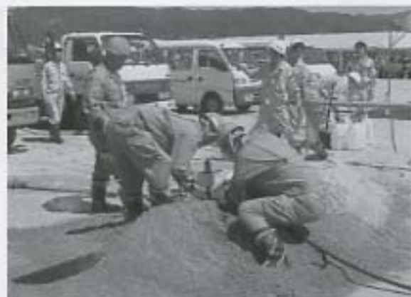
破損水道管の復旧訓練
